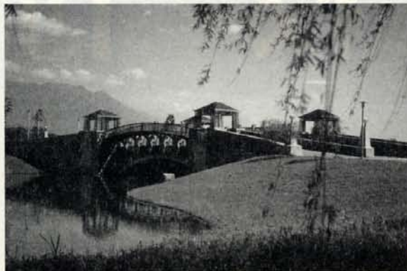
封面：東湖景觀橋。
