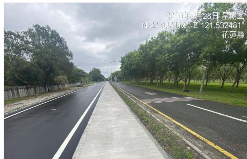
P07 永續提升人行安全計畫-東華大學周邊道路瓶頸及危險路口改善工程(西區)
